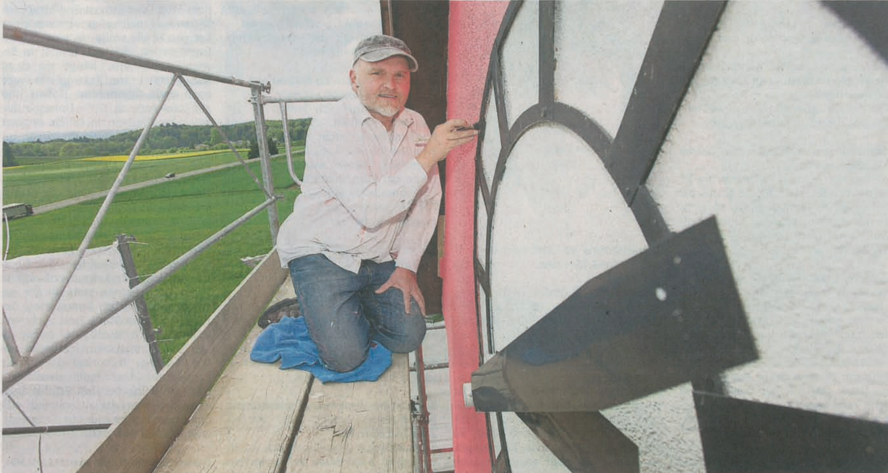
Reto Bärtschi malt 15 Meter über dem Boden am Kirchturm. Die Grundfarbe «Retorosa» ist aufgetragen, nun folgt ein Text. FOTOS: HANSPETER BÄRTSCHI
